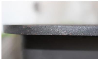
③ストーブ本体(鋼板部分)には、耐熱塗料を薄く吹き付け、それを2~3回繰り返します。
