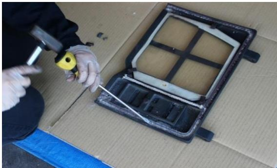
残っているガスケットセメントを、マイナスドライバーと金槌で剥がします。
